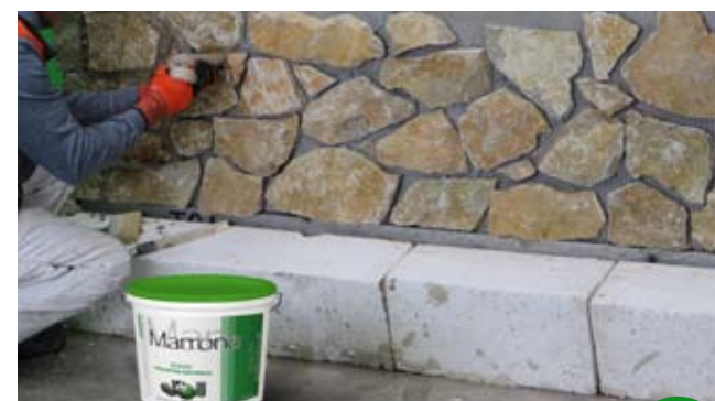
Sigillatura dei giunti. 7
